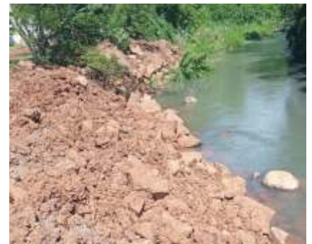
Contenção de desbarrancamento no arroio de Moreira
