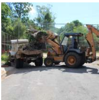
Intensificação dos trabalhos para a retirada de entulhos
