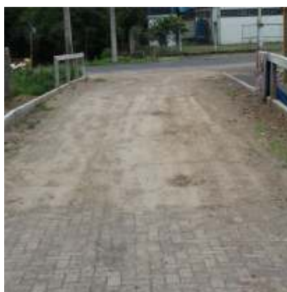
Conclusão da galeria de acesso ao Beco Catarina no Bairro Sander
