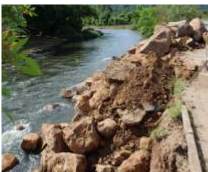
A obra contenção do desbarrancamento na Rua Kaiser também foi feita
