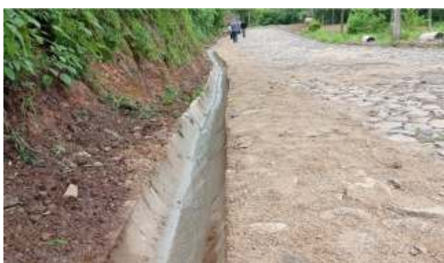
A Estrada Geral de Quilombo também recebeu atenção: foi instalada canalização e realizado reparos na via
