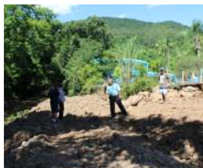
Obra de contenção do desbarrancamento no Arroio de Moreira e início da primeira etapa da pavimentação asfáltica da estrada geral de Moreira, foi outra importante obra
