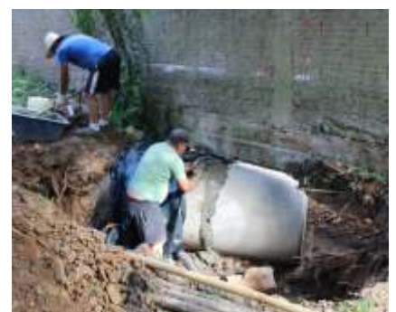
Foi realizado o conserto da canalização do córrego e construção de nova caixa coletora na Rua Anita Garibaldi
