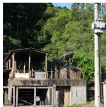
A usina de asfalto que estava sendo pouco utilizada nos últimos anos, e somente era possível usá-la mediante a locação de um gerador de energia, está sendo reativada
