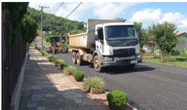
Foram utilizados cerca de 850 metros cúbicos de asfalto em recuperação de vias
